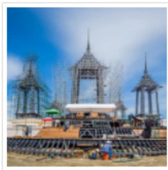
การก่อสร้างพระเมรุมาศ
