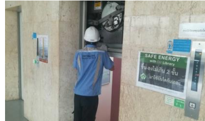
ภาพที่ 5 การตรวจสอบความปลอดภัยของลิฟต์โดยสาร
